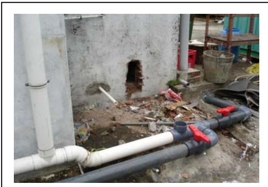
原糞渠開始改建 Pipe work
