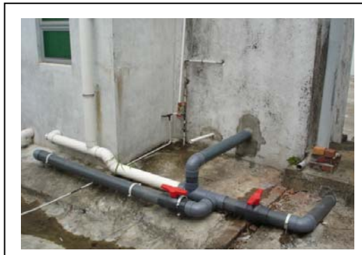
原糞渠改建完成 Pipe work Complete
